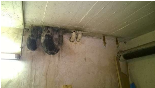
Strangeinführung Keller Regenwasser, Ab-wasser, Heizung, Kaltwasser
