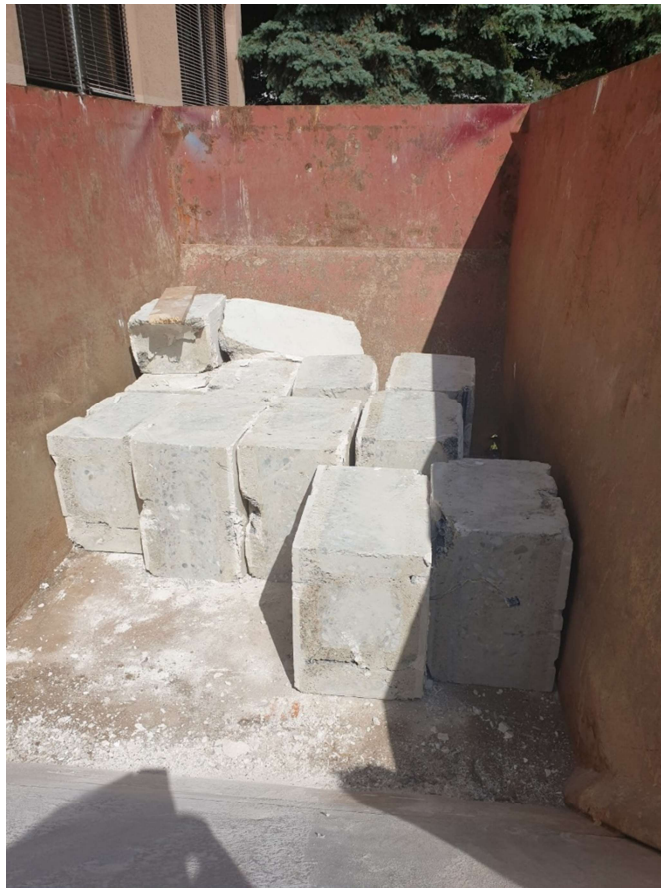
Bild: Die herausgeschnittenen Betonblöcke im Container
